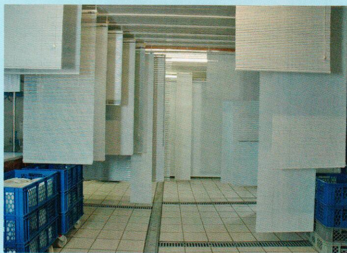
Flächenvorhänge und Plisseeanlagen nach dem Waschen in der Trockenanlage.
