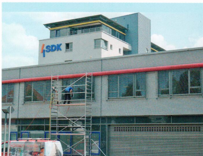
Bei der SDK – Süddeutsche Krankenversicherung wurden u.a. rund 1.300 m 2 Außenjalousien gereinigt.
