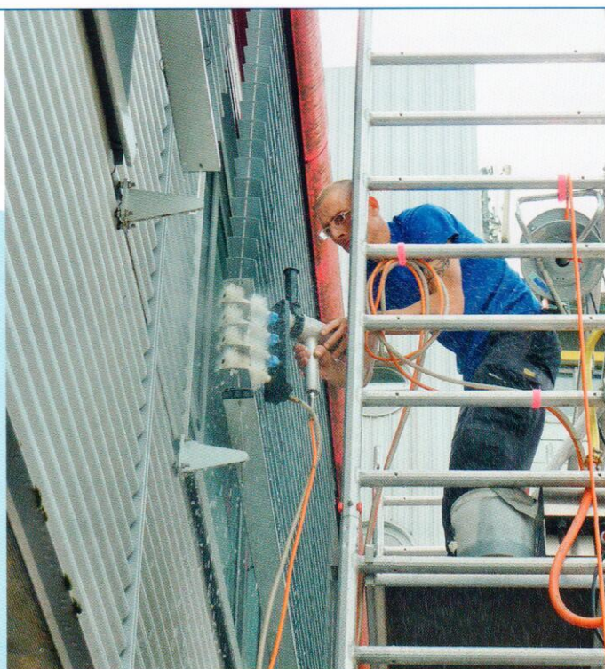
Bei den 80 mm breiten Lamellen kam ein mobiles Reinigungssystem zum Einsatz.
