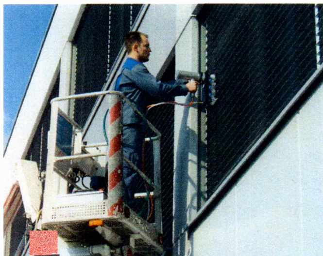
Das Gerät wird von einer Person bedient. Nötig sind eine Stromversorgung mit 230 V/16 A und ein Hauswasseranschluss 2–5 bar.
