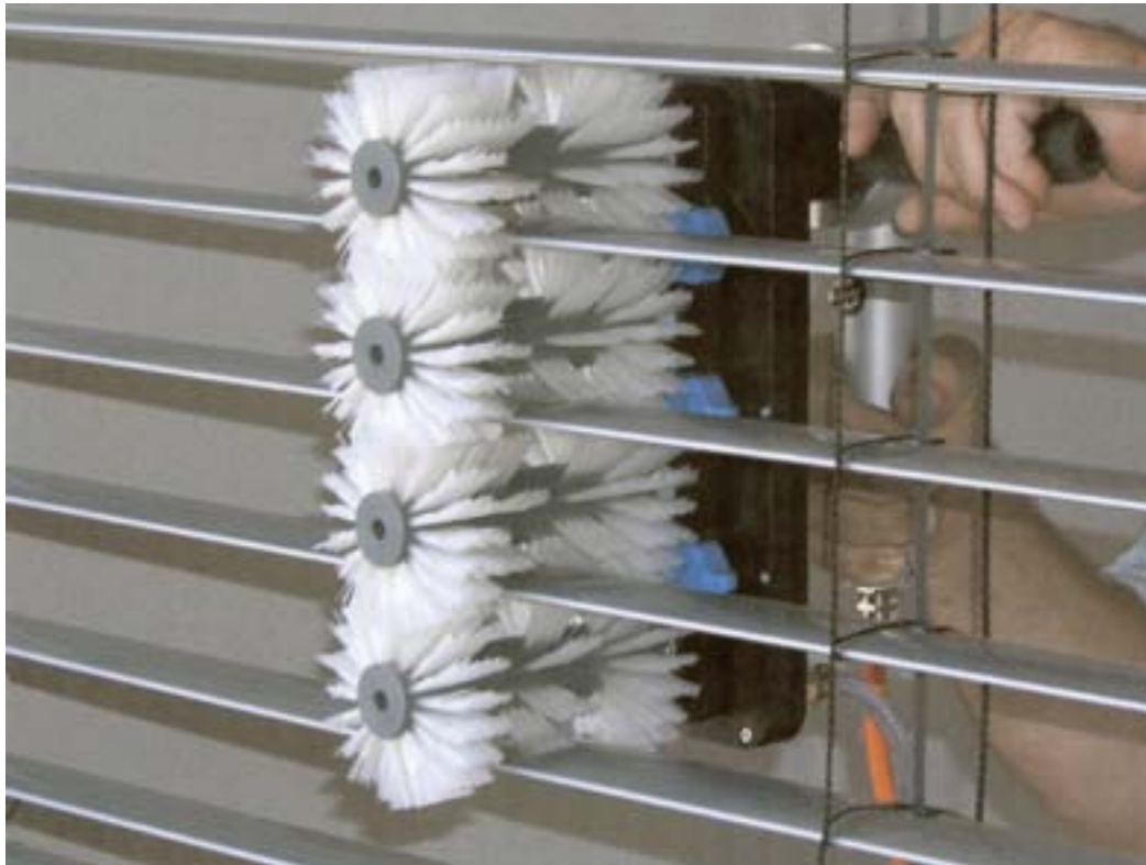
Auch Zug- und Leiterbänder der Jalousien können im gleichen Arbeitsgang mit gereinigt werden.
